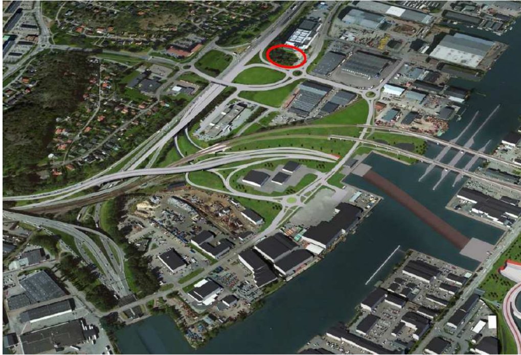
Figur 2 Bild över Tingstadsmotet efter ombyggnad (Trafikverket). Detaljplaneområdet är markerat med en röd ring.
